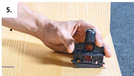
5. Placer l'élément d'assemblage dans le gabarit de perçage et d'alignement et l'insérer dans la rainure.
